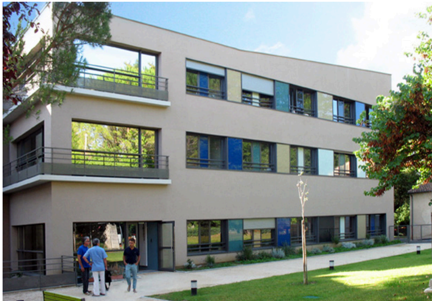
FAÇADE DE L'EXTENSION
